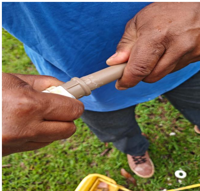
Figura 3 – Montagem das junções
