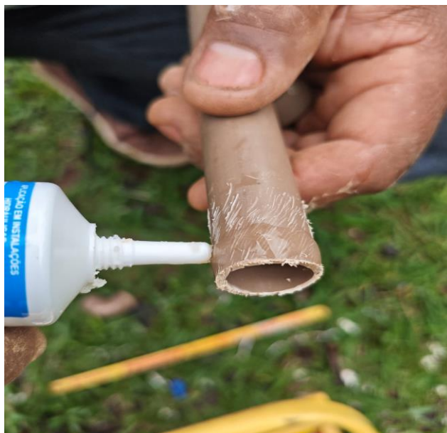
Figura 2 – Aplicação do produto após lixamento
